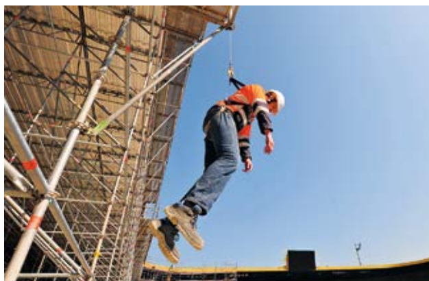
19 Eine abgestürzte Person muss innerhalb von 10 bis 20 Minuten durch Mittel vor Ort geborgen werden, ohne weitere Gefährdung des Verunfallten und des Retters.
