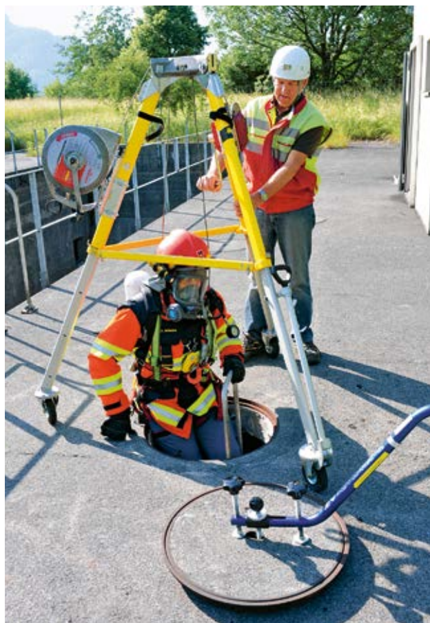
20 Einstieg in einen Schacht über eine Leiter. Sicherung durch Auffanggurt und Höhensicherungsgerät mit Rettungskurbel. Der Eingestiegene kann jederzeit von aussen mit der Rettungskurbel hochgezogen werden.
