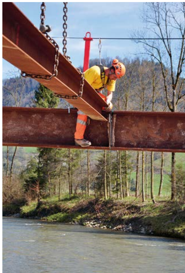
25 Montage einer Stahlkonstruktion mit Sicherung an einer horizontalen Lifeline.
